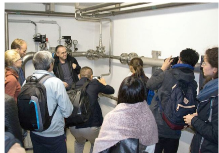
Exkursion zu einer Trinkwasseraufbereitungsanlage
