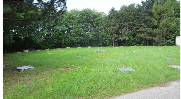
Die alte insitu Denitrifikationsanlage
